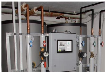
Verrohrung der Anlage sowie Anbindung an die Wärmeverteilung (Heizkörper / Flächenheizung)
