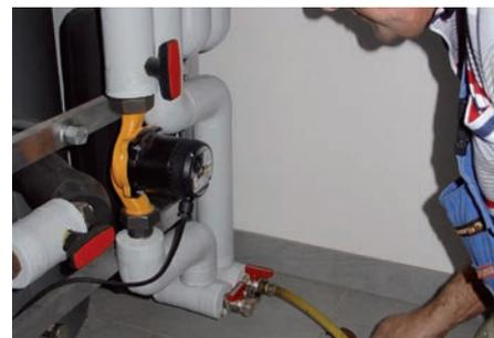
Befüllen des H2Q-Speichersystems und Entlüften des Heizungssystems
