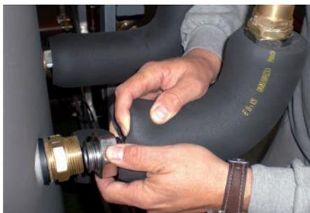
Verschraubung der Pufferspeicher mit Regelkreisen Heizen / Brauchwasser und Isolierung der Rohrleitungen
