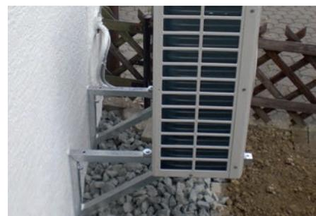
Aufstellung / Installation der Split-Wärmepumpe außen auf verzinktem Montagerahmen
