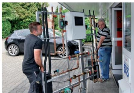
Einfacher Transport der auf Rahmengestell vormontierten Rohrgruppen und Umwälzpumpen
