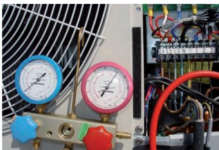
Anschluss und Druckprüfung der kältetechnischen Anlage / Außeneinheit
