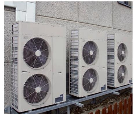
Aufstellung der Split-Wärmepumpe im Freien (Kaskadenschaltung ab Typ H2Q-2400MHK)
