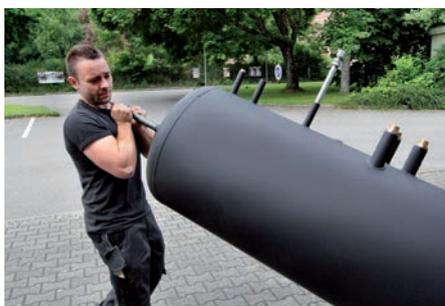
Einbringen des in Baugruppen angelieferten H2Q-Energiespeichersystems (Pufferspeicher)
